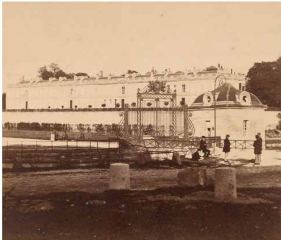
Armand Varroquier (1829-?), Charleville-Mézières. Le château d'Enghien vu de la grille d'honneur , vers 1859, tirage entre 1865 et 1867. Cette photo figure avec la légende Chantilly. Château de l'Emb[assadeu]r d'Angleterre sous le numéro 44 dans l'album Chemin de fer du Nord de Paris à Compiègne par Chantilly . ©RMN-Grand Palais Domaine de Chantilly-Michel Urtado
